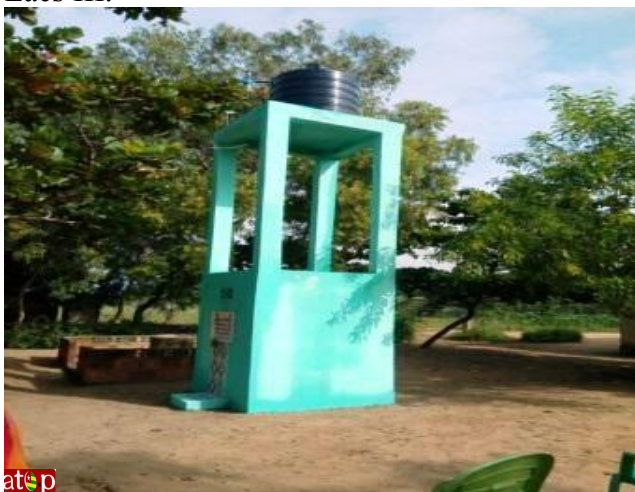
Un des forages remis
