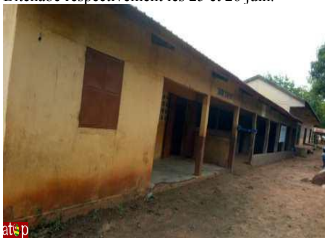
Vue du bâtiment dont le toit a été rénové
