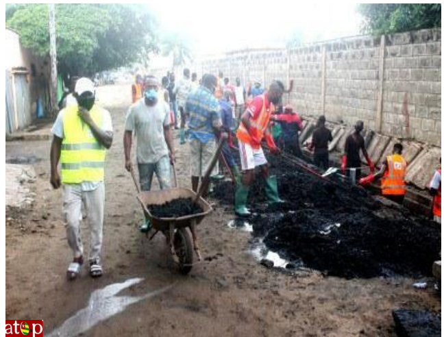
Les membres de l'association en opération de curage
